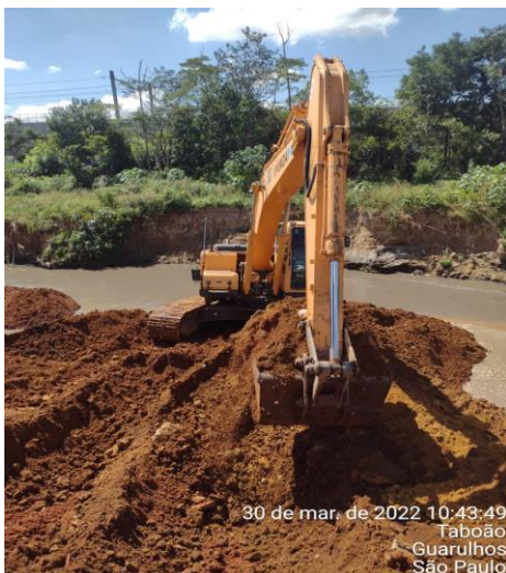
FOTO 3 – ESCAVAÇÃO DO CANAL
