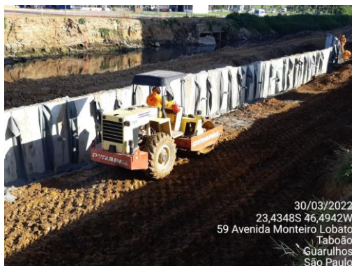
FOTO 2 – COMPACTAÇÃO DE REATERRO
